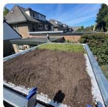
Substraat aanbrengen
